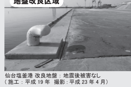
仙台塩釜港 改良地盤: 地震後被害なし(施工:平成19年 撮影:平成23年4月)
