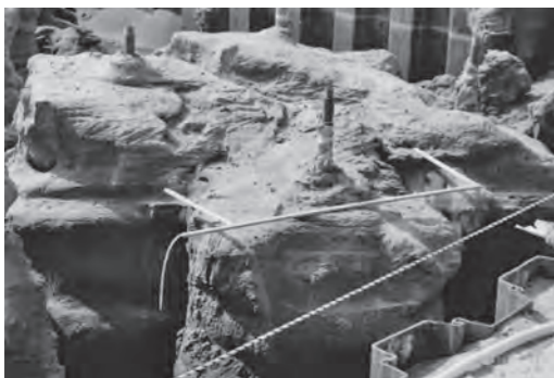
写真6 柱状浸透注入工法・エキスバック工法による低炭素グラウト(ハイブリッドシリカ)の高強度大径柱状連続固結柱
