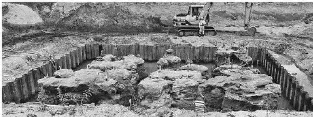
実証実験の現場
